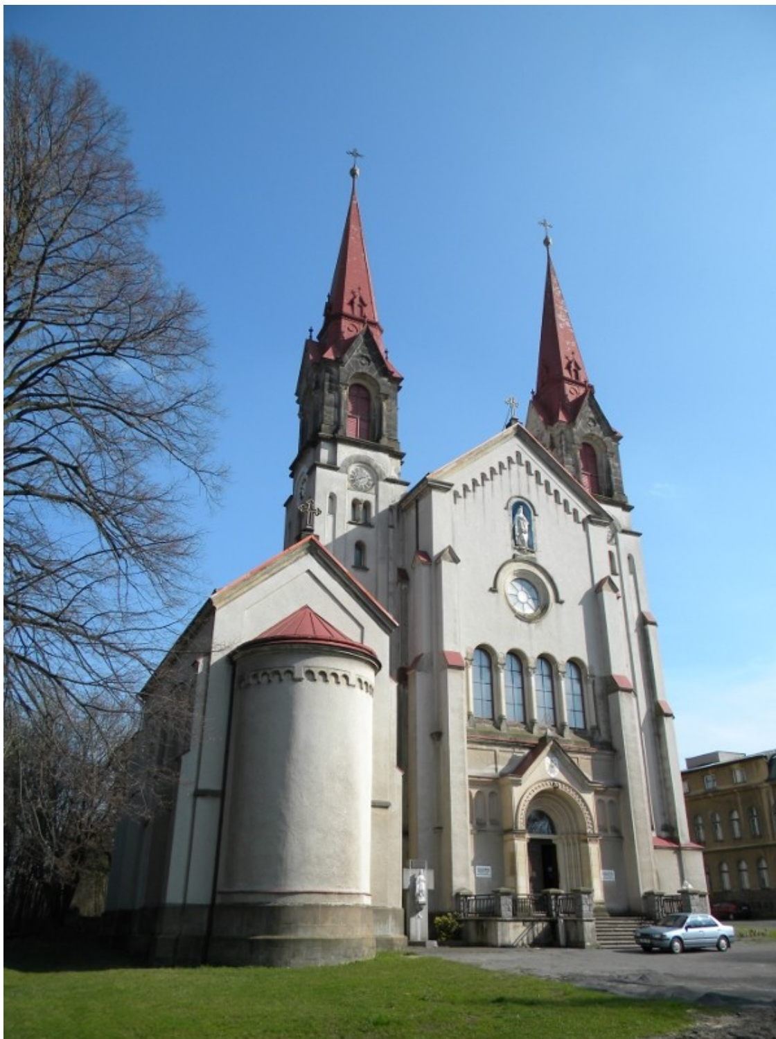
Obr. 3.9 Bazilika Panny Marie Pomocnice křesťanů ve Filipově
