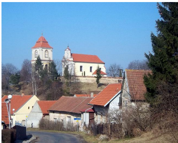
Obrázek 6 Pohled na kostel sv. Václava se zvonící
