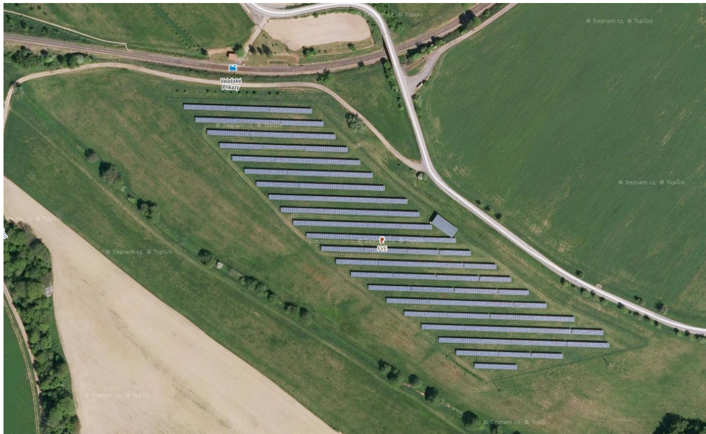
Obr. 4: Fotonvoltaická elektrárna na území obce Valašské Příkazy
