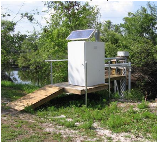
Obr. 12: Zařízení sloužící ke kontrole a sledování kvality vody
