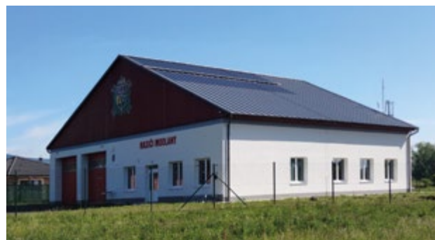
“Neviditelná” fotovoltaická elektrárna na střeše hasičské zbrojnice obce Modlany – příklad „neinvazivní“ instalace v energetice
