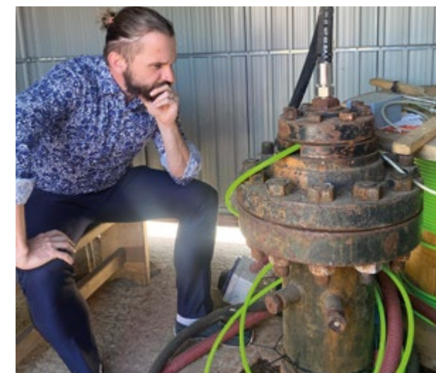
Vyústění dvoukilometrového zkušební geotermálního vrtu v litoměřickém výzkumném centru Ringen
