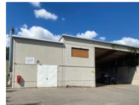
Výtopna na biomasu (dřevní štěpku) v duřynské obci Bechstedt
