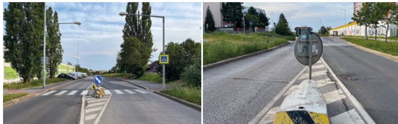
Omezený rozhled na nestavebním dělicím ostrůvku
