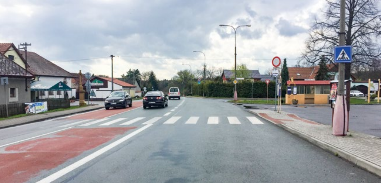
Takto dlouhý přechod, navíc vedoucí doprostřed zastávky, nikdy legitimní nebyl, přesto prokazatelně existuje přes 20 let
