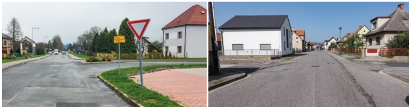
Chybějící vyznačení hranice křižovatky a absence dodatkové tabulky jen málo zamezují psychologické přednosti jízdy přímo
