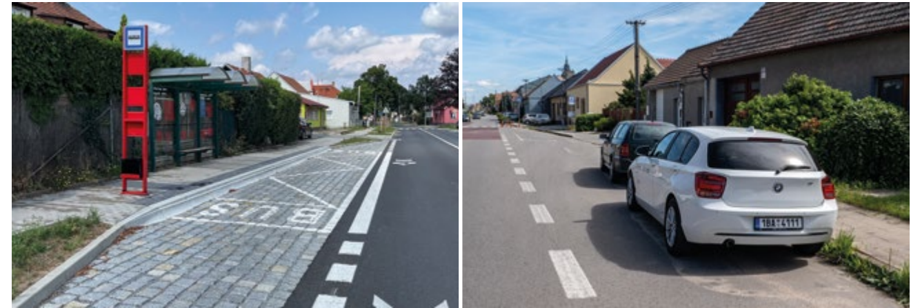
Nesprávné užití vodorovného značení umožňuje legální stání v nájezdech
