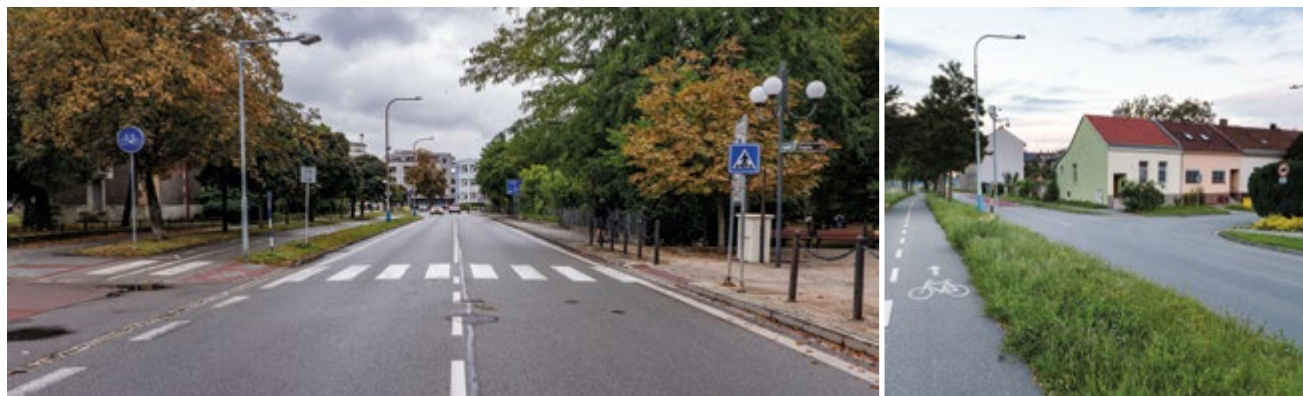
Překročená maximální délka přechodu v místě, kde měl být ostrůvek
