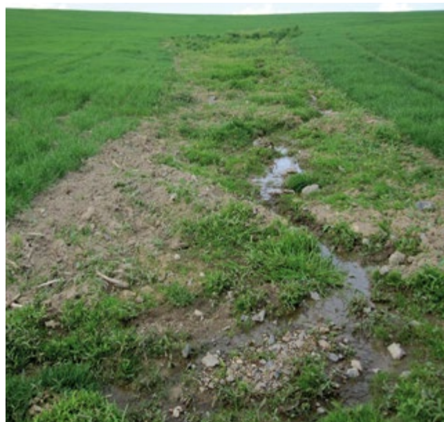
Obr.40: Poškozená meliorace - voda si vždy cestu najde
