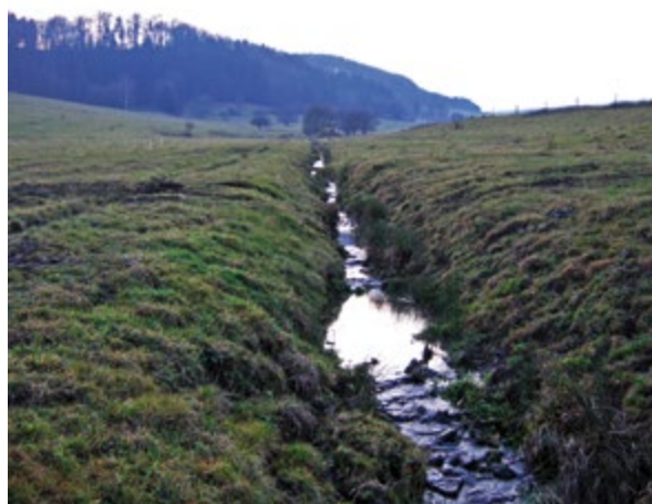
Obr.61: Obnova vodního toku (foto: J. Malík)
