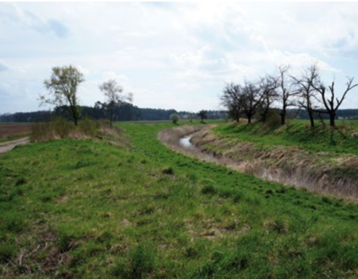
Obr.21: Technická úprava řeky Výrovka v Kostelní Lhotě
