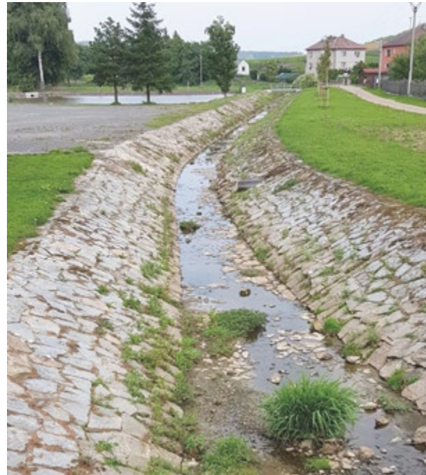
Obr.15: Úprava Holoubkovského potoka
