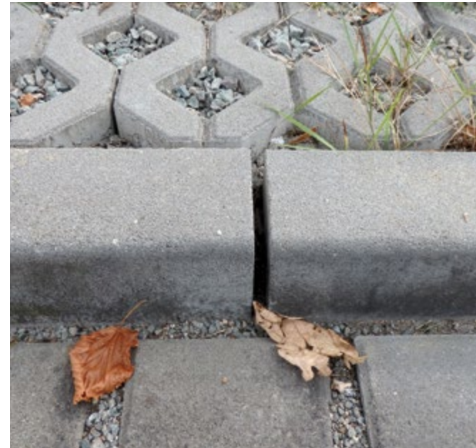
Obr.68: Detail spáry v obrubníku (foto: E. Wagnerová)
