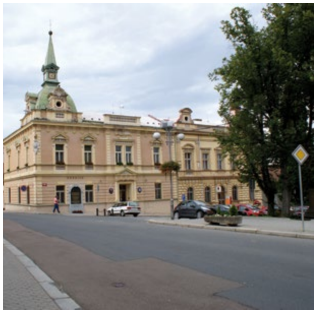
Obr.27: Plochy komunikací - dešťová voda odtéká do kanalizace
