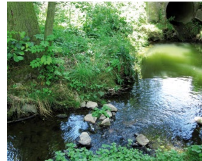
Obr.25: Výpust dešťové vody do potoka
