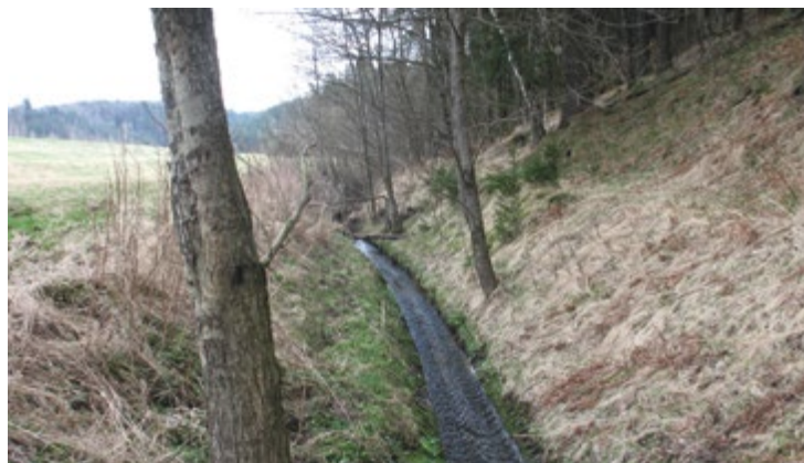
Obr.72: Původní kanalizované koryto
