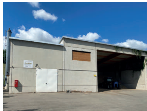
Výtopna na biomasu (dřevní štěpku) v duřinské obci Bechstedt
