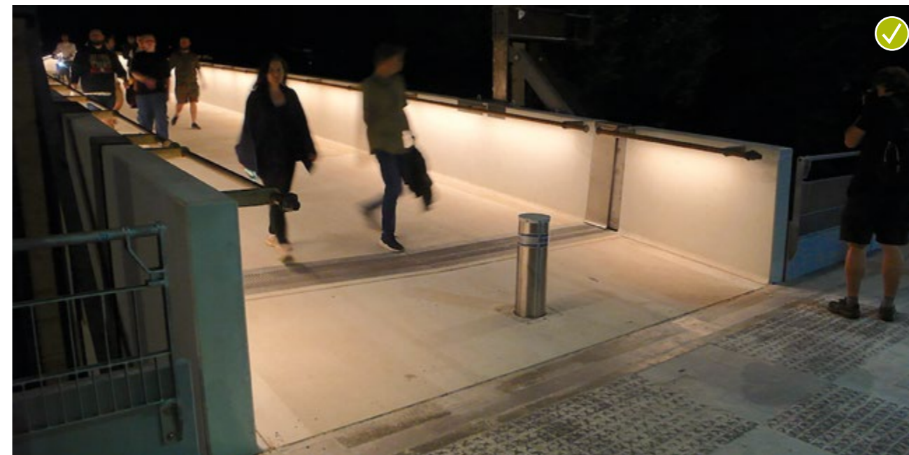
V projektu lávky HolKa, oceněném za architekturu, si dal autor záležet na integraci LED-pásků do zábradlí tak, aby bylo zcela zamezeno riziku oslnění chodců a zároveň omezen únik světla do okolního prostoru, zejména do řeky pod lávkou
