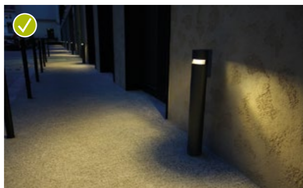
Nová budova NKÚ se z průměrné stavby rozhodně vymyká i velmi vysokou úrovní venkovního osvětlení, kde jsou využity kvalitní sloupky s matným černým reflektorem a různou geometrií dle konkrétní pozice v prostoru
