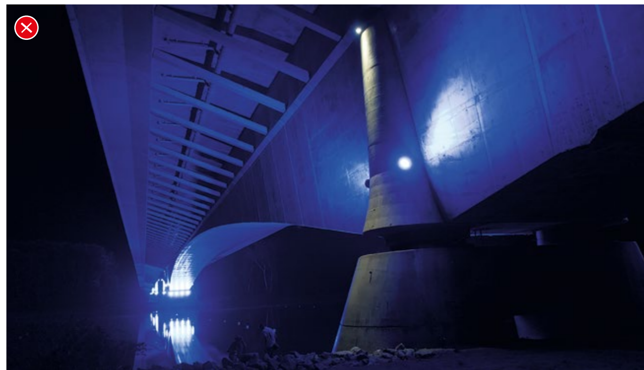
Extrémní případ použití dekorativního osvětlení mostu silnými zdroji modrého světla v přírodní oblasti Lužný les. Zde lze opravdu mluvit o „devastaci“, protože toto osvětlení si turisté ani místní občané při svých cestách neprohlédnou (Bratislava).
