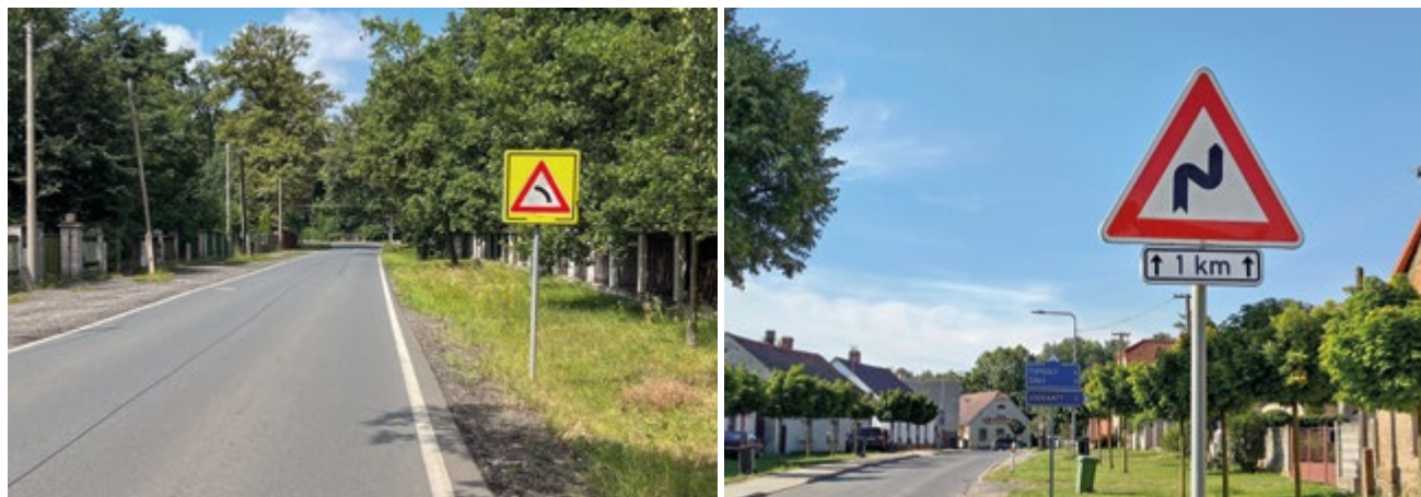
Předčasně a zbytečně umístěné značky zatáčky
