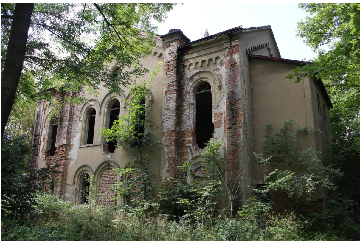
Obr. 3.3 Objekt bývalého evangelického kostela v Růžové, ukázka brownfieldu, foto Filip Mágr
