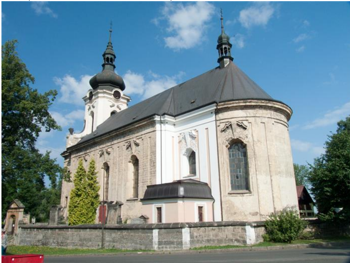
Obr. 3.7 Pozdně barokní kostel Nanebevzetí Panny Marie
