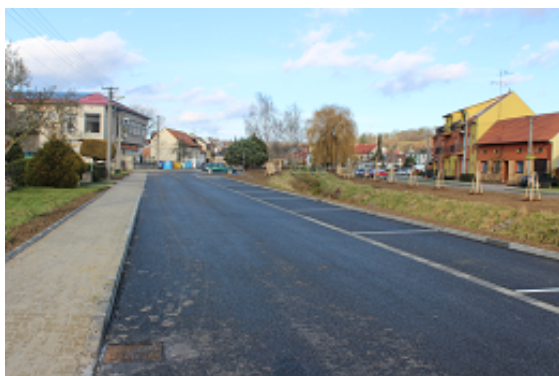
Obrázek č. 7: Komunikace rozšířená o podélné stání a chodníky v ulici za potokem
