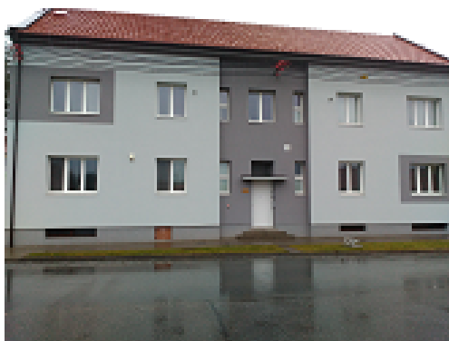
Obrázek č. 8: Zdravotní středisko po zateplení a obnově v r. 2017
