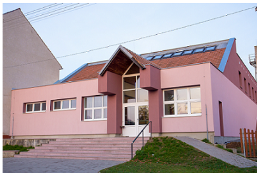
Obr. č. 11: Víceúčelové kulturní a sportovní zařízení po zateplení v roce 2013
