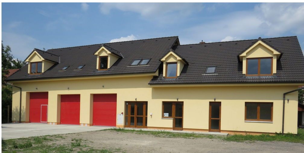
Hasičská zbrojnice Cítov, zdroj: obec Cítov
