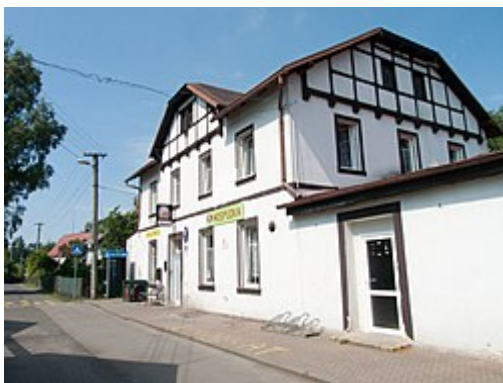
Obecní úřad obce Labská Stráň
